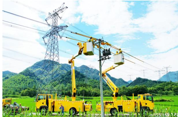
7月6日,国网池州市贵池区供电公司带电作业人员在墩上变电站10千伏湖湖112线154号杆更换柱上真空开关。该公司坚持“能带电、不停电”原则加强电网运维检修,确保电网安全稳定运行。
