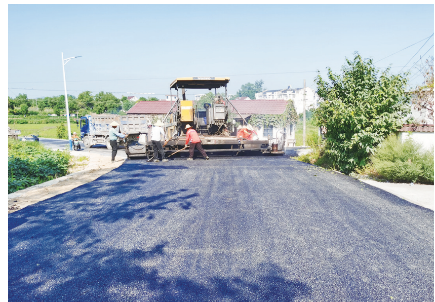
近日,在蓉城镇建新村,施工人员将原有6.5米宽的水泥混凝土路面铺装成沥青路面。工程完工以后,道路焕然一新,行车舒适度大大提升,能更好地服务当地经济发展。 通讯员 蓉宣 摄
