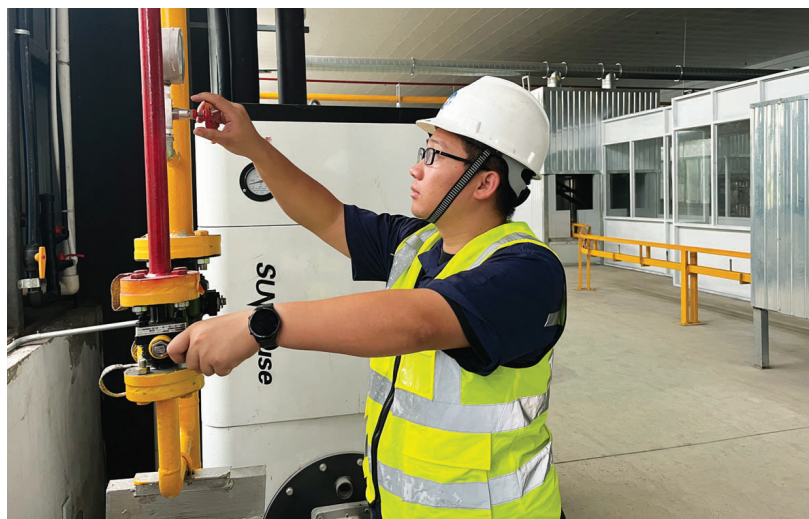
▲青阳港华安检员正在安徽通久科技有限公司厂房内进行燃气安全检查。
