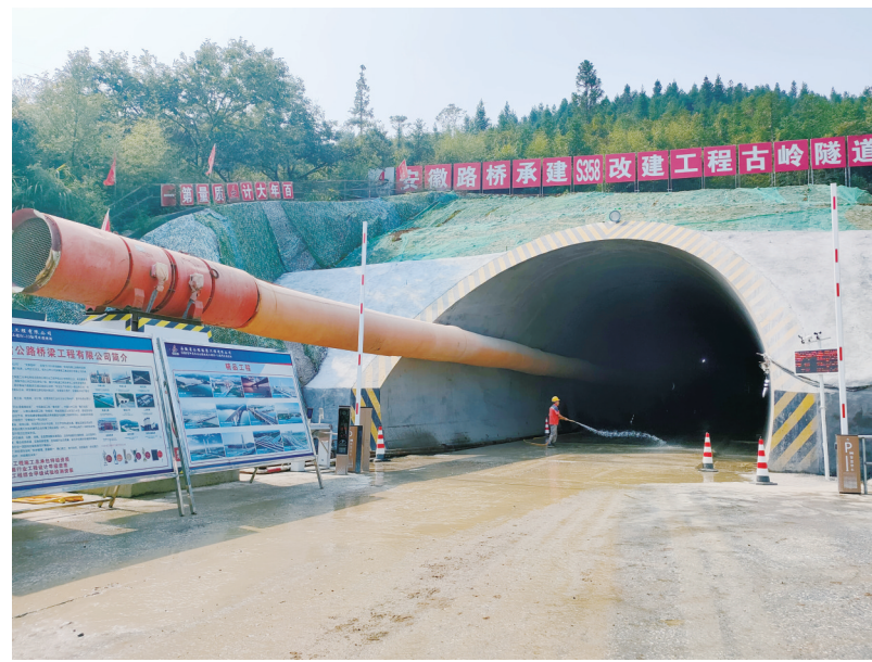
工人正在清洗道路，抑制扬尘，图为施工现场。
