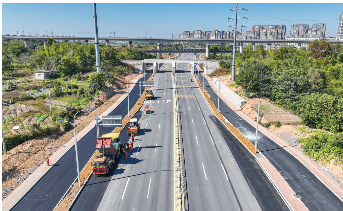
10月23日,池州市天竺湖片区基础设施一体化提升工程(长江南路延伸段附属工程)施工现场,工人正在进行沥青面层铺设和道路绿化种植,预计11月中旬可全面完成。该项目完工后,不仅大大改善市民的出行条件,缓解交通压力,而且提升了池州主城区南入口的景观效果。 记者 张延鹤 摄
