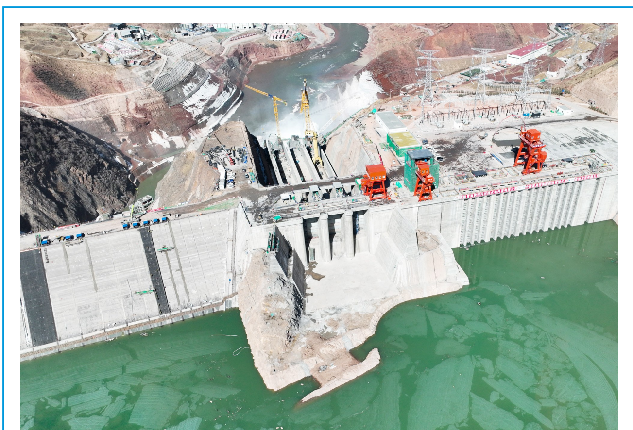
这是4月1日拍摄的玛尔挡水电站（无人机照片）。
